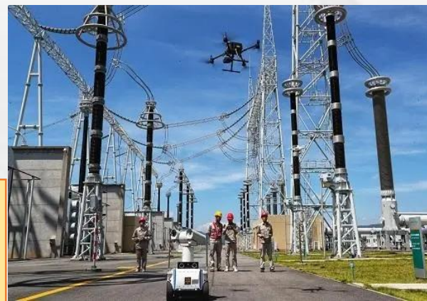
输配电线路施工与运行
